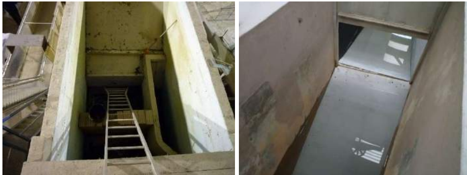
Figuras 8 e 9. Limpeza do depósito e rampas montadas no murete da comporta de guilhotina.
