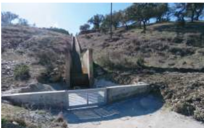
Grelha metálica laminada no descarregador de cheia.
