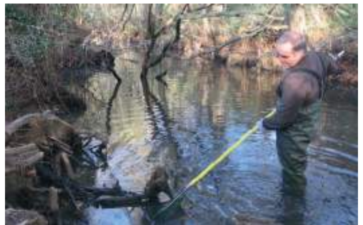
Instalação de barreira elétrica amovível na ribeira do Abrilongo (SIC de São Mamede).
