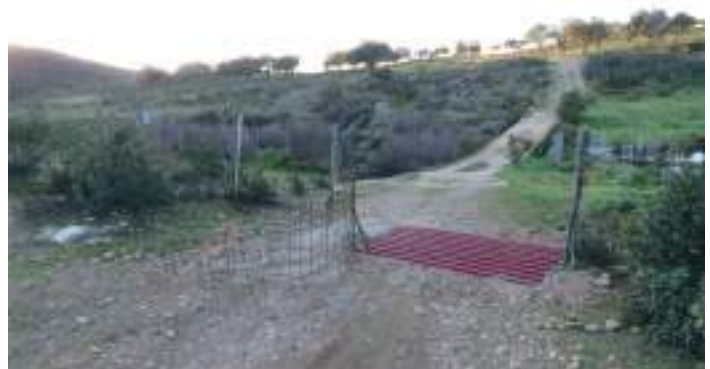
Ribeira do Murtigão - Instalação de 2 passagens canadianas em pontos de atravessamento da ribeira, para permitir a circulação de viaturas e impedir a passagem de gado.
